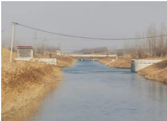
潍高公路下游西王家村翻板闸
