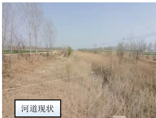
韩公彦桥~庆淄路桥段河道治理情况
