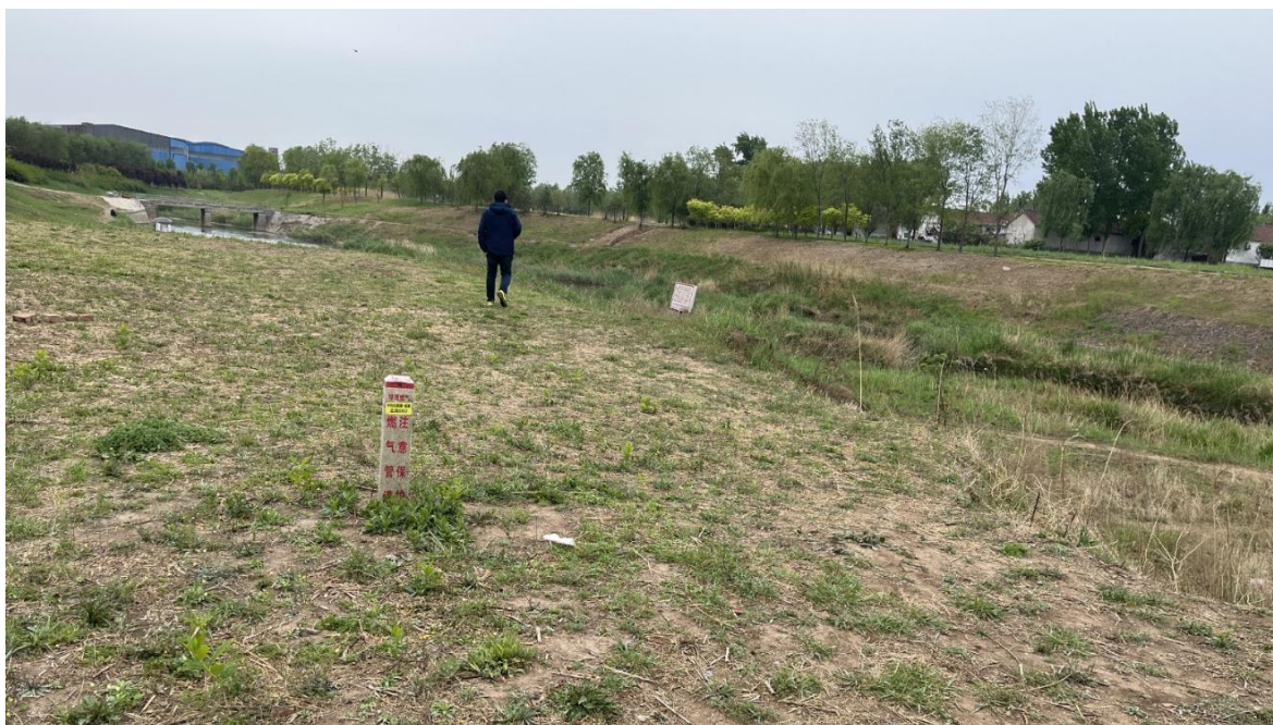
图 2.3-1 经济开发区傅家镇殷家村东（桩号 12+950）穿河天然气管道现状
